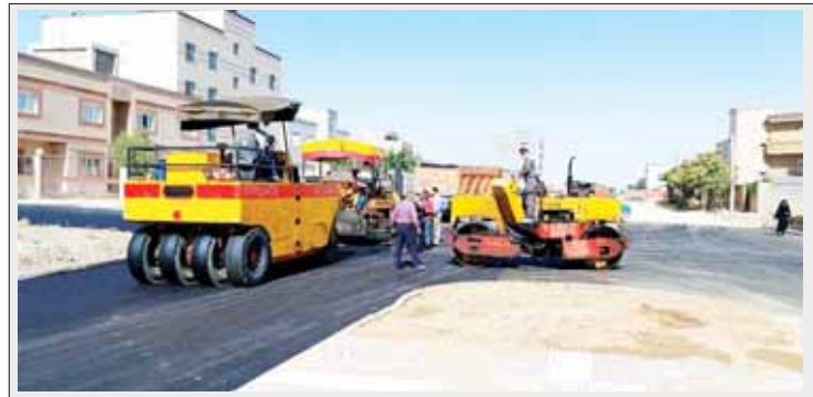
ماشین در حال کار در محل پروژه شهرداری بهار
