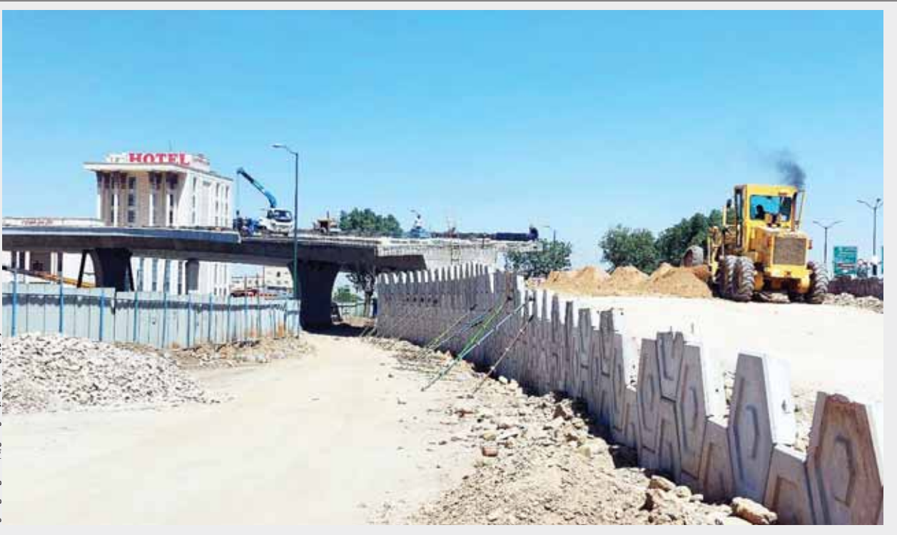
پل غدیر، امنیت پل مهمتر از افتتاح است. شهردار همدان، یاسر زارعی، در جریان بازدید از محل ساخت پل غدیر.
