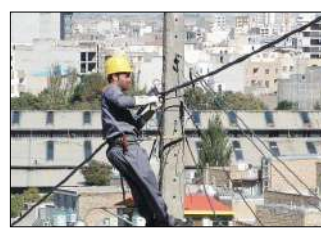
معاون مهندسی شرکت توزیع نیروی برق استان مرکزی گفت: در سال گذشته ۴۰۲ کیلومتر شبکه سیم مسی در استان مرکزی به کابل خودنگهدار تبدیل شده است. مهندس داود منصوری با بیان اینکه یکی از اقدامات شرکت برق استان در راستای مقابله با سرقت سیم‌های مسی شبکه برق تبدیل ۵۰ درصدی شبکه سیمی فشار ضعیف در استان به کابل خودنگهدار است، افزود: از ۸ هزار و ۳۷۳ کیلومتر شبکه فشار ضعیف هوایی استان، ۴ هزار و ۳۶۴ کیلومتر آن به کابل خود نگهدار تبدیل شده است که باعث ارتقاء تأمین برق خود نگهدار است. منصوری ابراز امیدواری را فراهم کرده است. وی تصریح کرد: افزایش قابلیت اطمینان در مقابل شرایط جوی و اتفاقات ناشی از برخورد اشیاء خارجی، رفع
