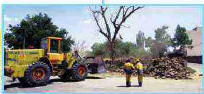
در حال انجام عملیات آسفالت‌ریزی
