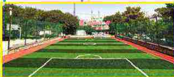
این فضای ورزشی شامل کفسازی، نصب پوشش چمن، جروار، محکمت، ایجاد روشنایی و فن کشی است
