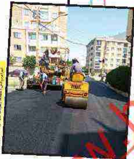
در حال انجام عملیات آسفالت‌ریزی
