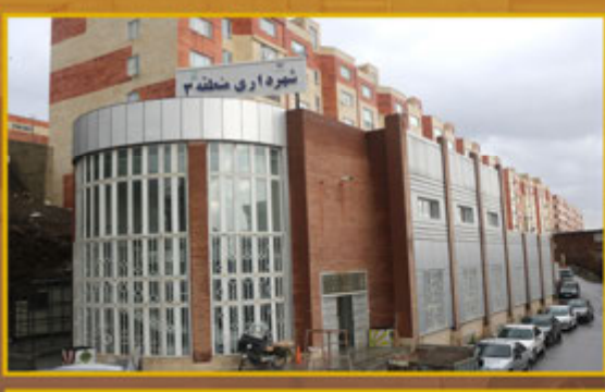
تملك ساختمان شهرداری منطقه سه سنندج
