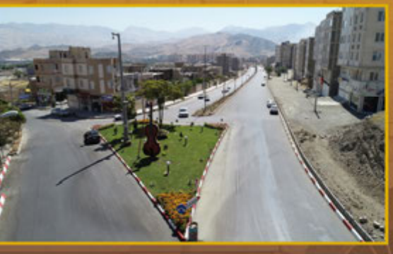
احداث بلوار ۳۶ متری دگران (بلوار کامکارها)
