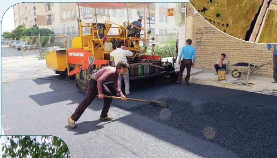
عملیات پاجرایی روکش آسفالت در سطح منطقه ۲
