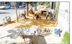
عملیات پیاده‌سازی سطح منطقه
