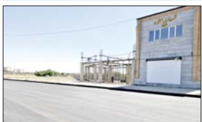
احداث اتاق واقع در برزگره حضرت امام خمینی (ره) جنب ساختمان اداری ناحیه سه شهرداری منطقه سه همدان
