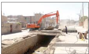
عملیات تخریب دال‌های بتنی قدیمی و پرداخته جهت پوشش مجدد و ساندنچ بلوار شهید آیت الله رئیسی (مهر شهنا)
