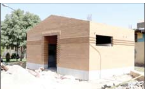
احداث نمازخانه پاک شهروند واقع در بلوار شهید سردار همدان
