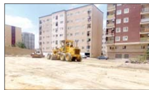
عملیات زیرسازی و تسطیح در سطح منطقه سه شهرداری همدان
