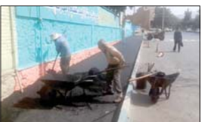
عملیات لکه‌گیری آسفالت به صورت دستی واقع در سطح شهرداری منطقه سه همدان
