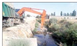
عملیات لایروبی رودخانه‌های سطح منطقه سه شهرداری همدان
