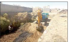
عملیات خاکبرداری و انحراف، پرداخته جهت دیوارکشی و پوشش رودخانه واقع در بلوار شهیدای سلامت
