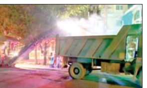
عملیات تراش آسفالت به صورت شبانه در دستگاه جیت اجرایی آسفالت
