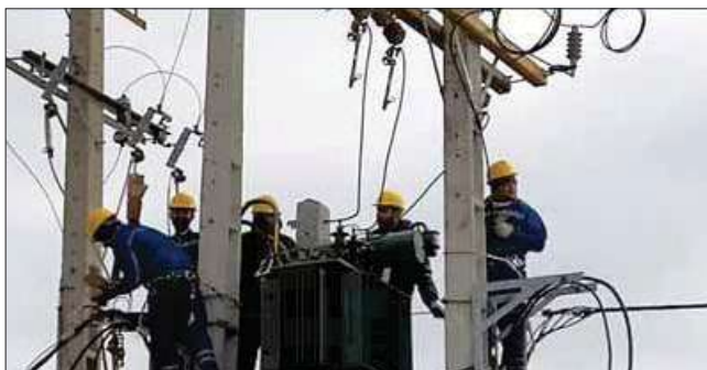
• نصب ترانسفورماتور بلوار رسالت
