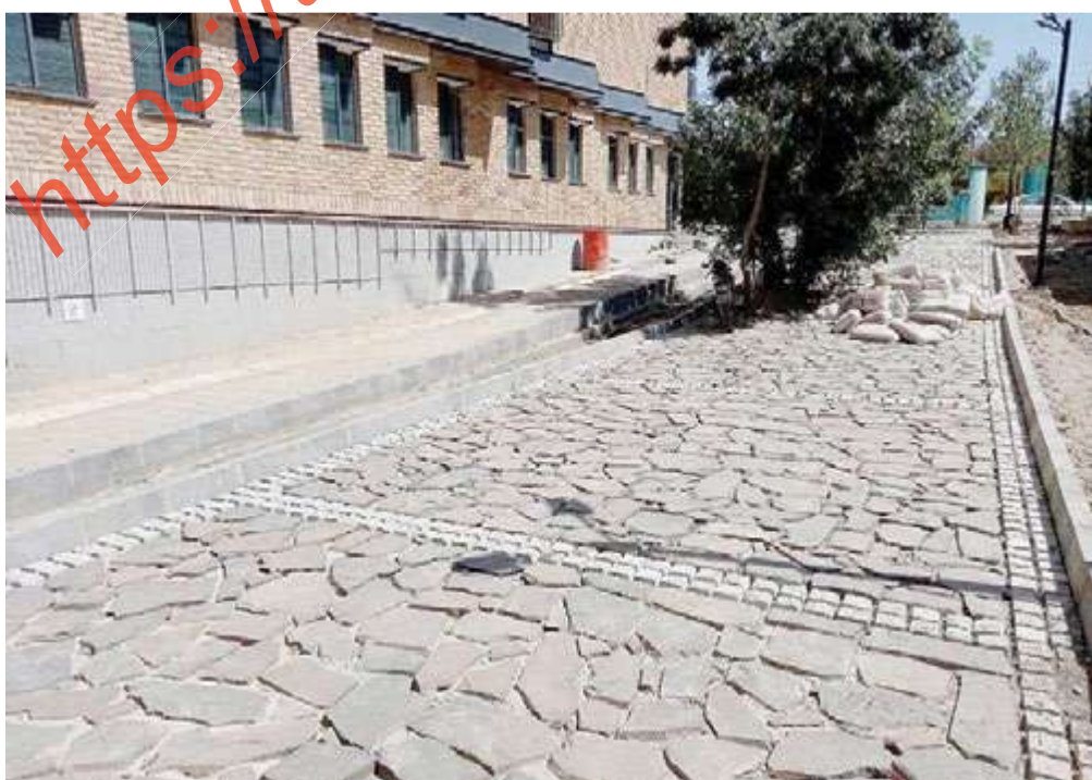
عملیات زیرسازی و پیاده‌روسازی پروژه احداث پارک کمال‌آباد
