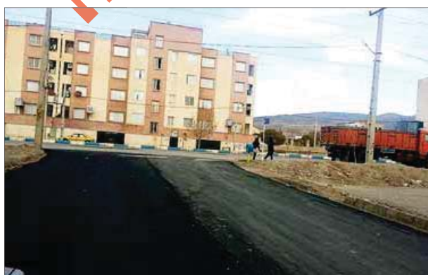
اجرای عملیات آسفالت در شهرک میدری
