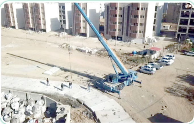
▲ دیوار کشی و پوشش رودخانه واقع در انتهای بلوار شهدای سلامت به سمت کوی قاسم آباد
