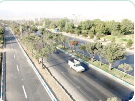
▲ احداث کندرو به طول ۱٫۴ کیلومتر واقع در بلوار شهید سردار همدانی
